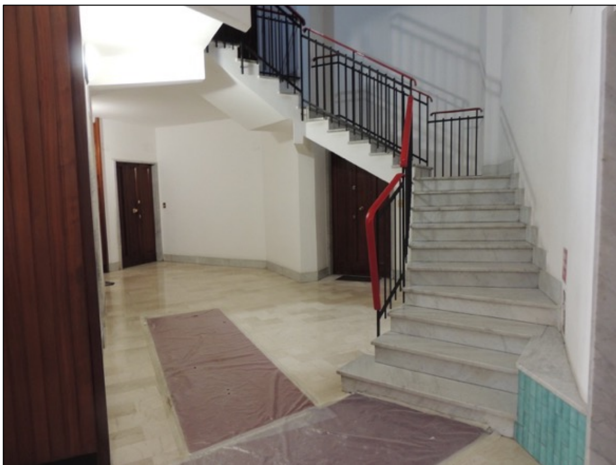
Foto 06 – il vano scale al piano terreno
