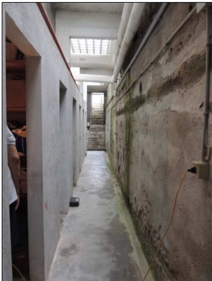
Foto 5 – il corridoio di distribuzione delle cantine verso sud ovest, visto dal fondo verso la scala di accesso
