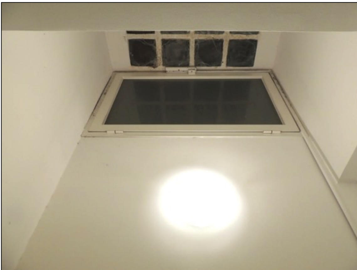
Foto 31 – il bagno: la finestra a vasistas che si apre sull'intercapedine del fabbricato. La porzione di soffitto (ad altezza 3,67m) realizzata in blocchetti di vetro cemento per prendere luce dal cavedio del fabbricato
