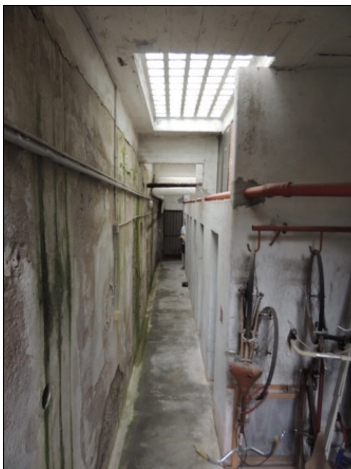
Foto 3 – il corridoio di distribuzione delle cantine verso sud ovest. La cantina interno S è la penultima in fondo a destra.
