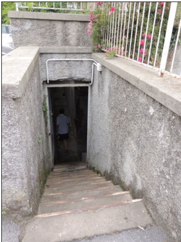
Foto 2 – l'accesso al locale cantine
