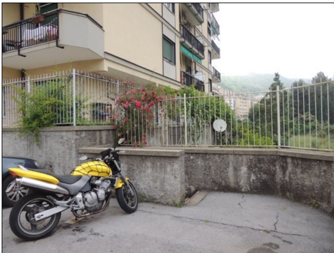
Foto 6 – l'accesso al locale cantine posto sotto alla fioriera del terrazzo dell'immobile
