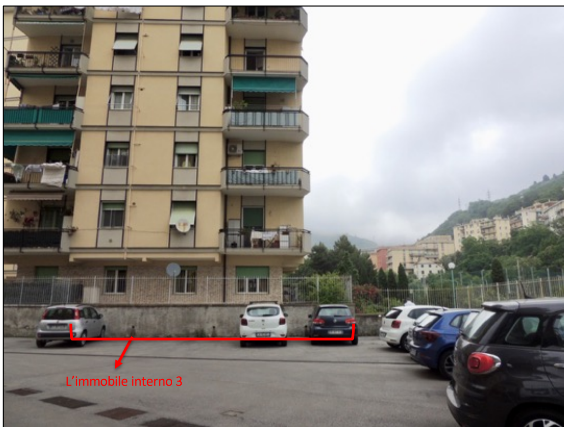
Foto 5 – il fabbricato: vista esterna dell'immobile interno 3
