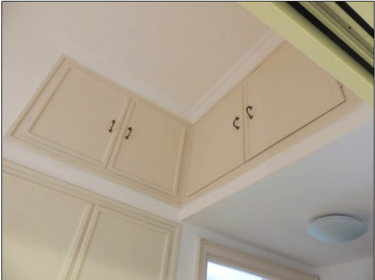
Foto 27 – corridoio: porzioni del soffitto sono state ribassate per consentire la realizzazione di ripostigli
