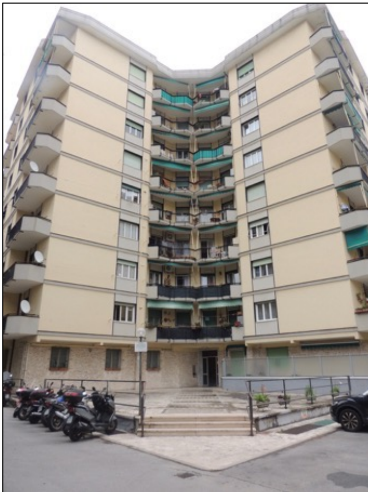
Foto 1 – la facciata principale del fabbricato di via Apparizione 20
