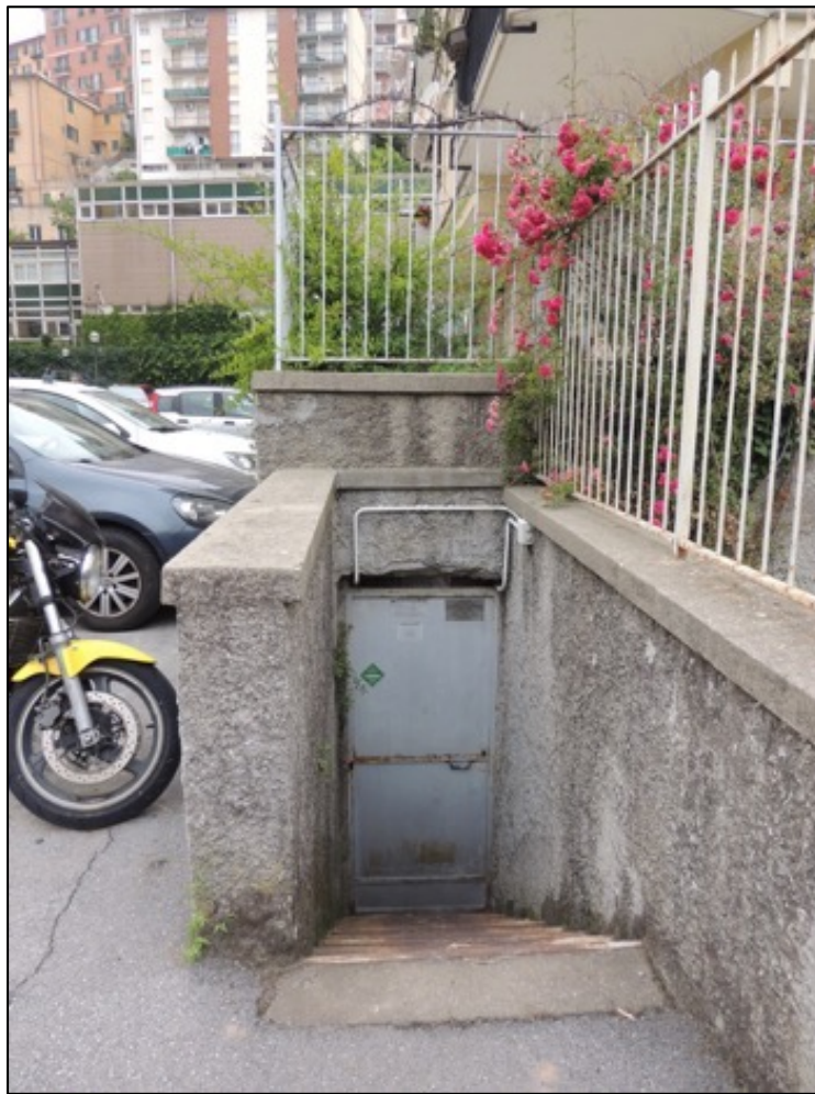
Foto 1 – la scala che scende al locale cantine, in corrispondenza della fioriera del terrazzo dell'interno 3
